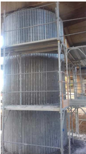
Pila circolare nella fase di armatura. Realizzazione di un viadotto in Sardegna
